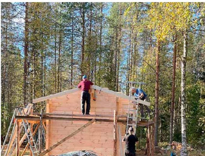
Kattorakennelman teossa kirvesmies Toivo Raassina, sähkömies Arvo Åke ja termieristäjä Valde Piironen.
