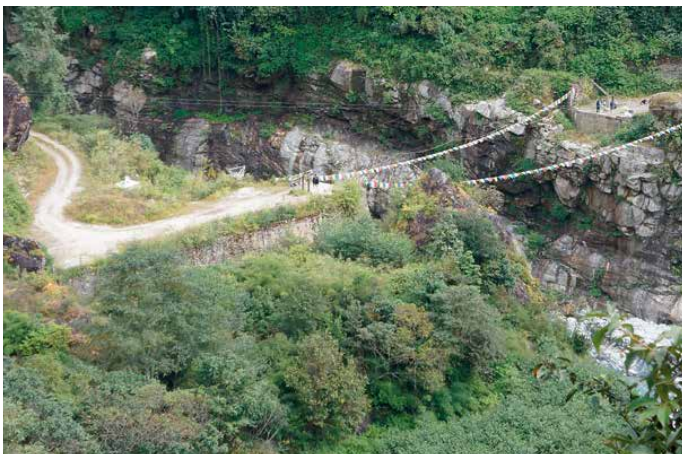
Melamchi-joen tulvat v. 2021 aiheuttivat suurta tuhoa. Tällä siltapaikalla ihmisiä ja tavaroita hinataan joen yli korissa köydestä vetämällä.
