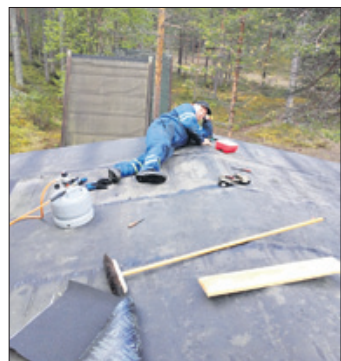
Kari korjaa varaston kattoa. Kuvat: Pauli T. Komonen
