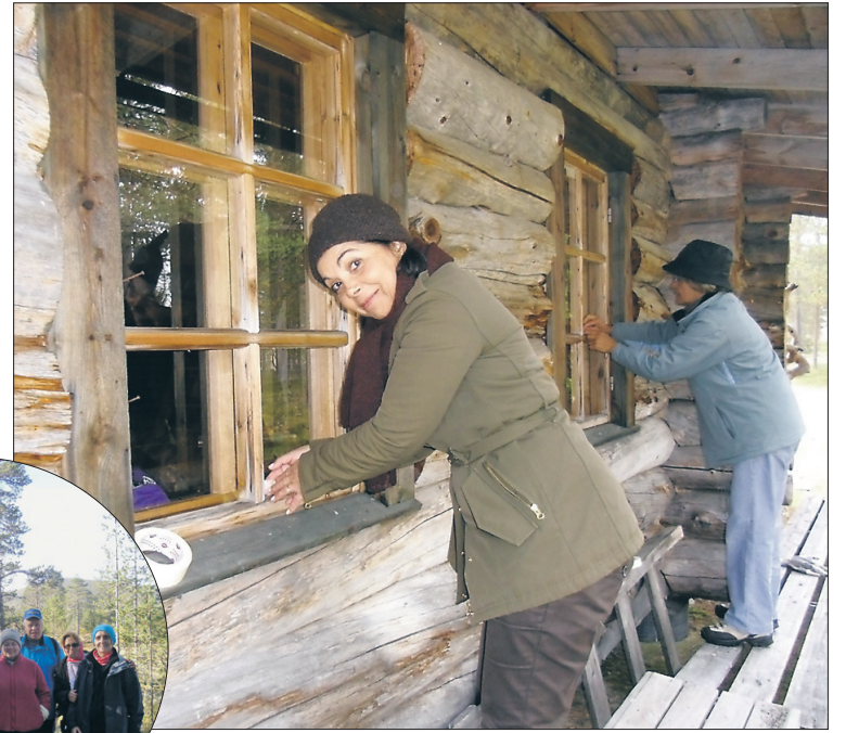
Kelokämpän ikkunat vuosihuollossa.
